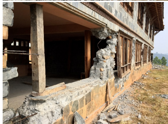
Doppelbild: Demolierte Bimeshowr-School mit begonnenen Baumaßnahmen.
