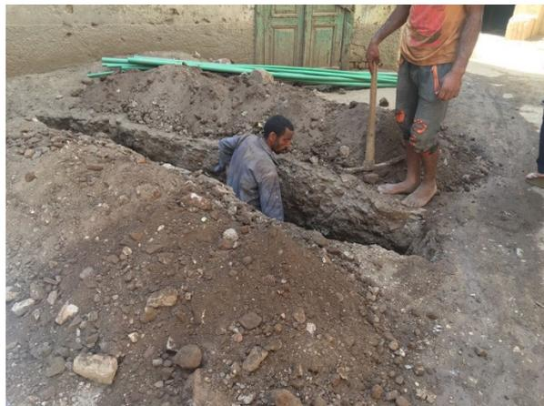
Verlegung von Trinkwasseranschlüssen in einem Vorort von Sohag.
