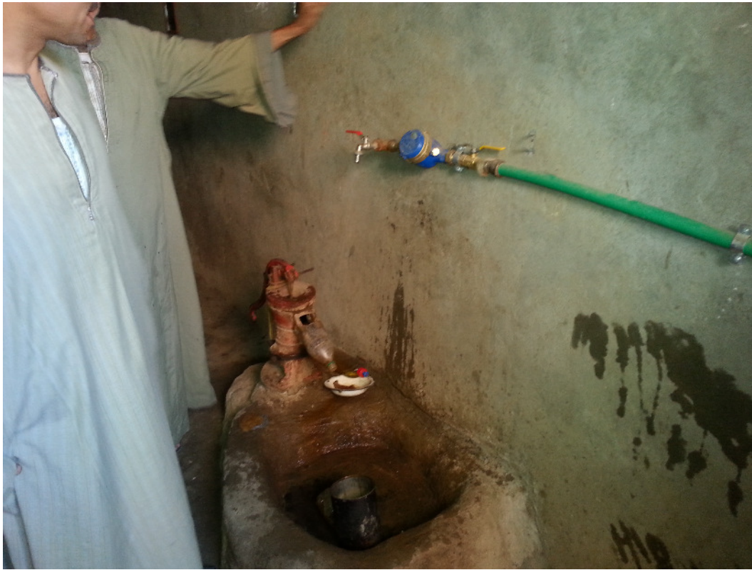
Neuer Trinkwasseranschluss mit Wasserzähler
