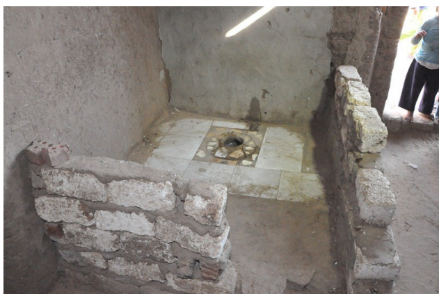
Toilette (Sickergrube unterirdisch)
