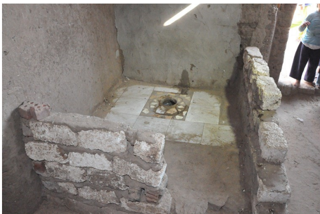
Toilette (Sickergrube unterirdisch)
